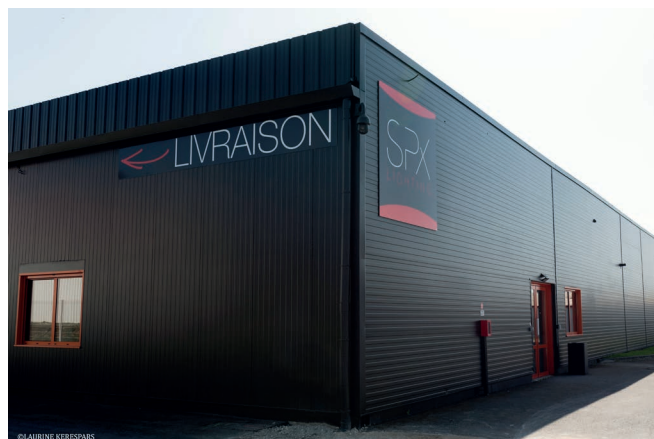
Sito di produzione SPX Lighting - Issoudun - France
