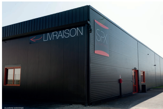
Produktionsstandort SPX Lighting - Issoudun - Frankreich
