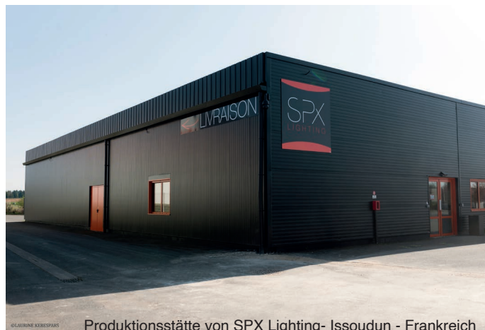
Produktionsstätte von SPX Lighting- Issoudun - Frankreich
